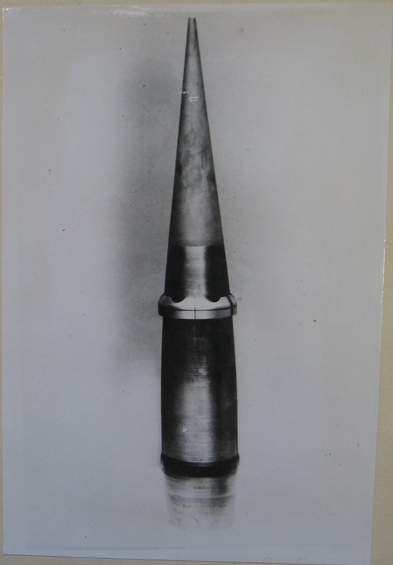
Projectile explosif Brandt de 75 m/m à ceinture de guidage éjectable
